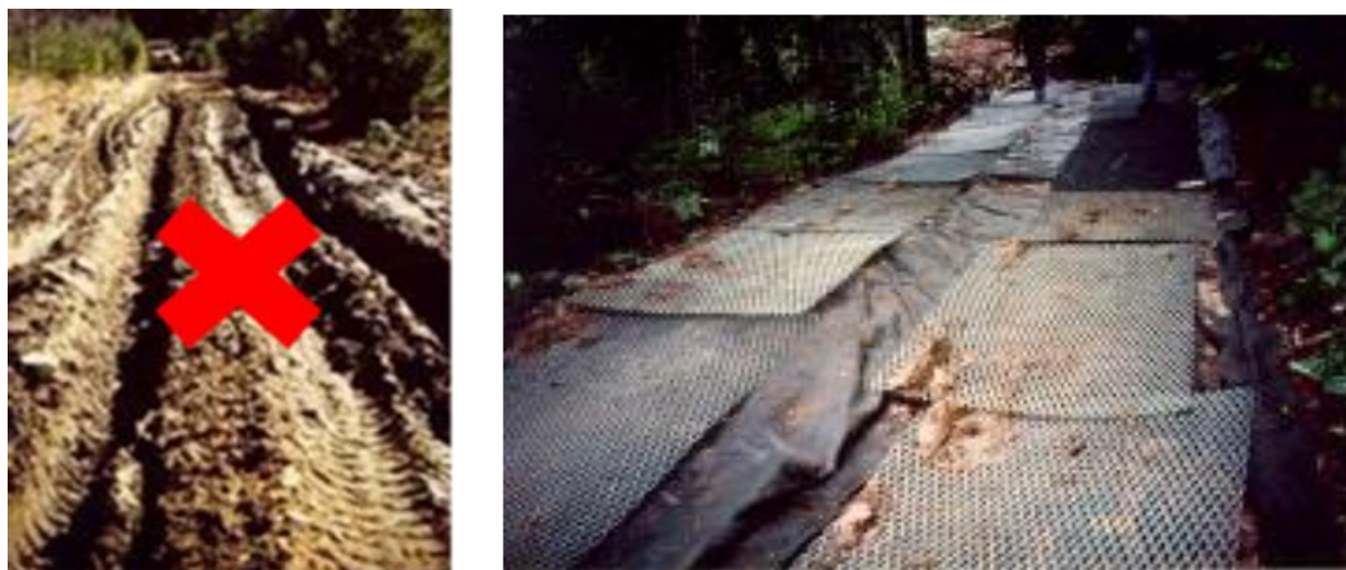
Fig. 62. Exemple de dispositifs de protection des sols
